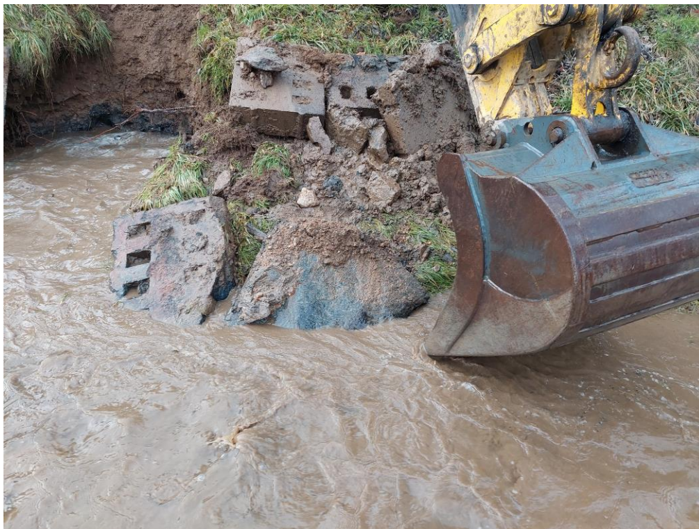
Obr. Kopaná sonda na břehu koryta se zjištěným opevněním a záhozovým kamenem
