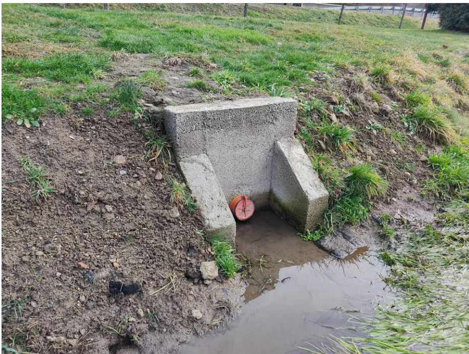
Obr. Nové výtokové odpadní potrubí s betonovým čelem
