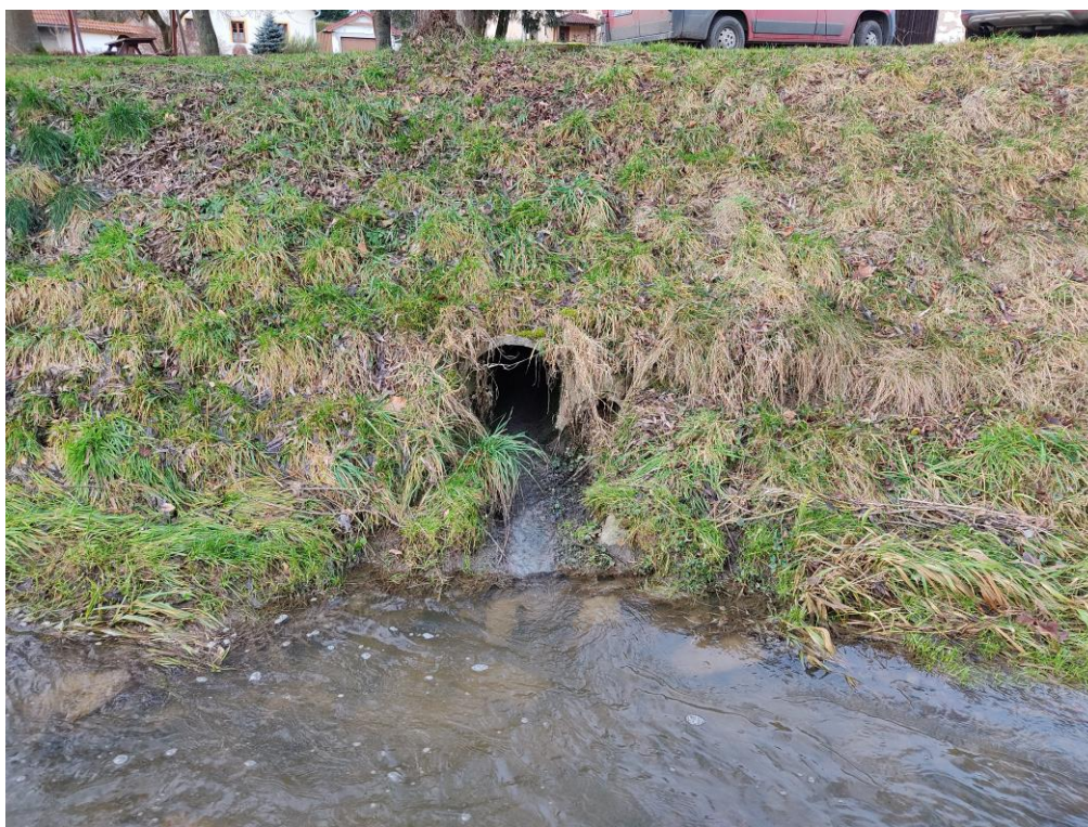
Obr. Výtokové potrubí z odpadní kanalizace, potrubím DN 500
